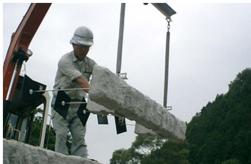
製品吊上げ状況
