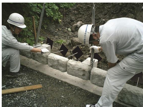
製品据付状況
