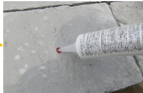
シリコン充填状況
