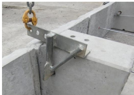
吊孔への吊冶具差込み状況
