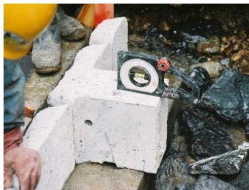
据付け位置・勾配調整状況
